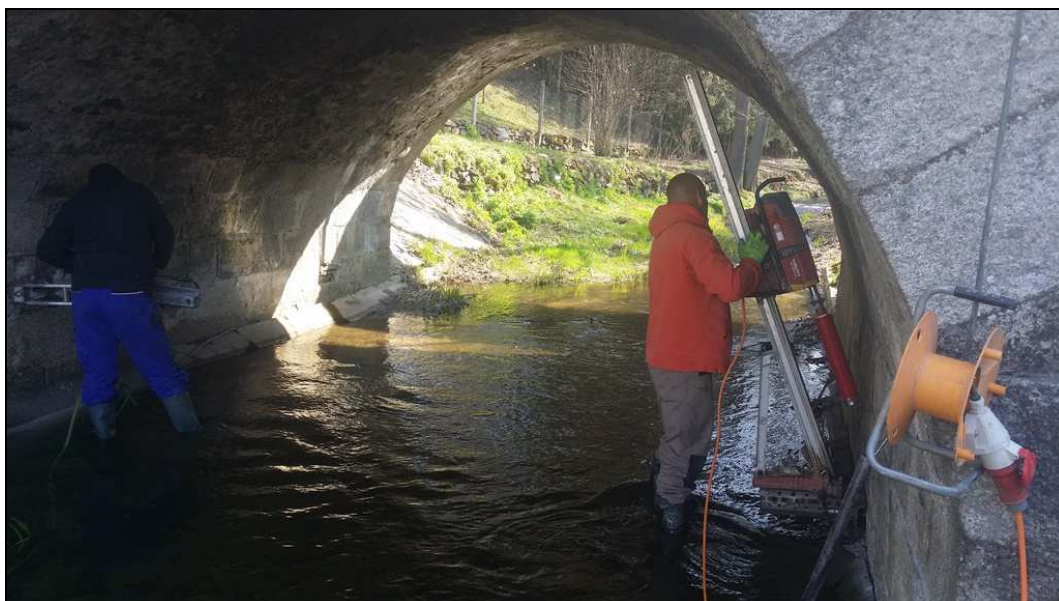
Obr. č. 3 – Pohled na provádění jádrových vrtů
