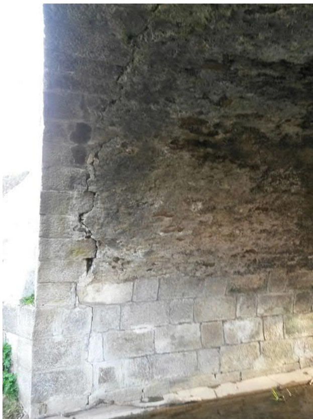
Održení věnce nosné konstrukce vlevo
