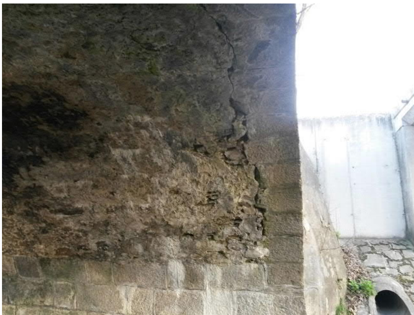
Odtržení věnce nosné konstrukce vpravo
